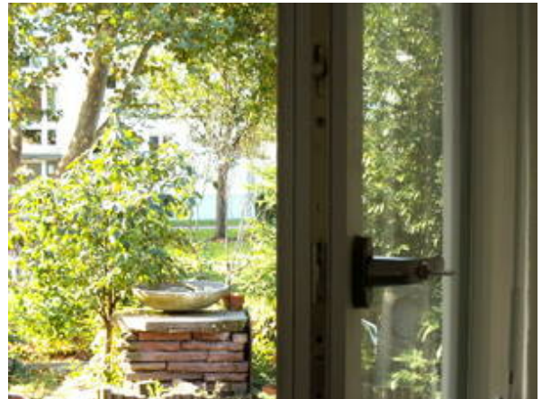
So einfach wie wirkungsvoll: Mit dem richtigen Heizen und Lüften lässt sich Schimmel vermeiden Foto: Energie-Fachberater.de
